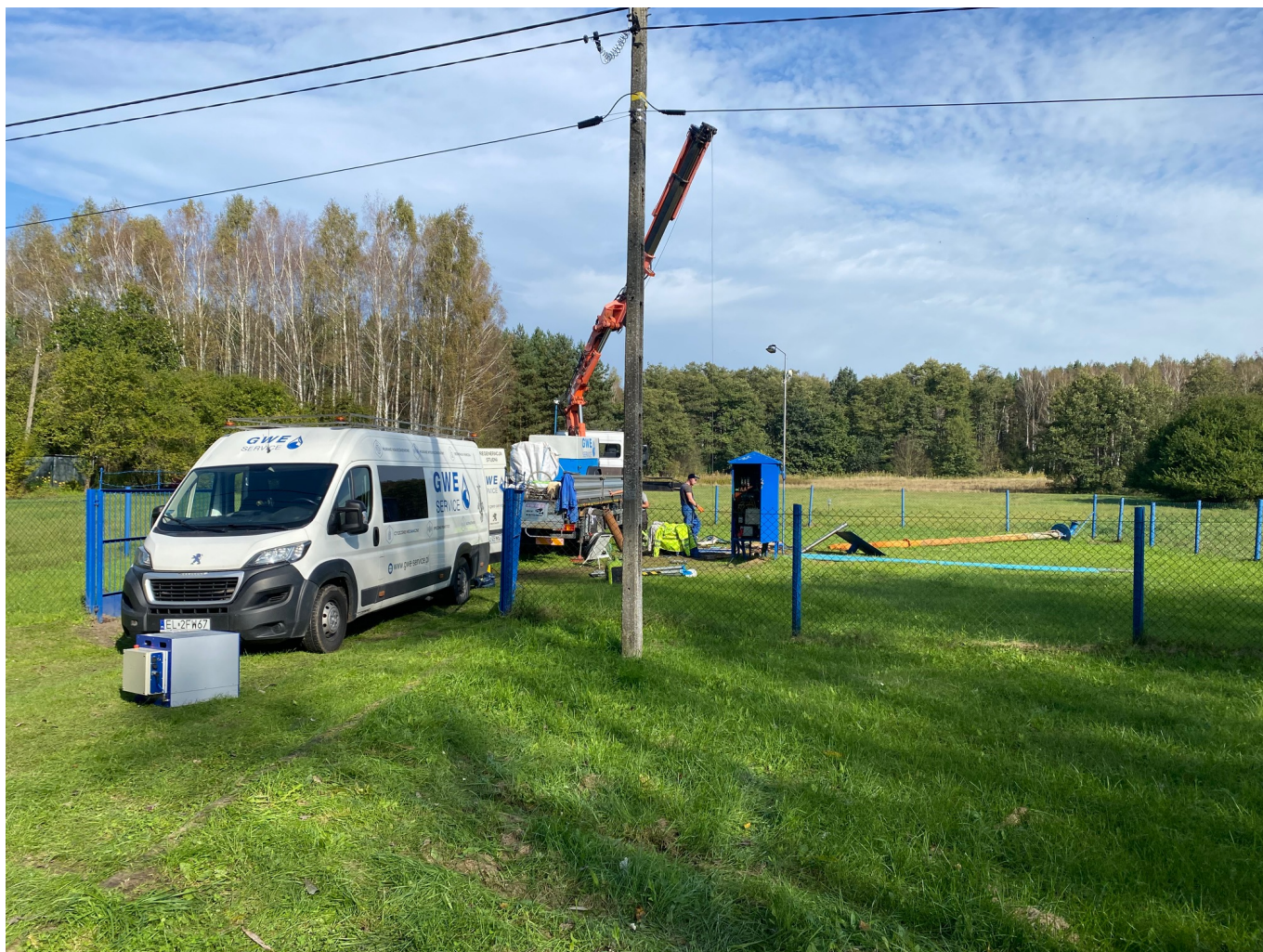
Renowacja studni nr 1 ujęcie Radzików II
