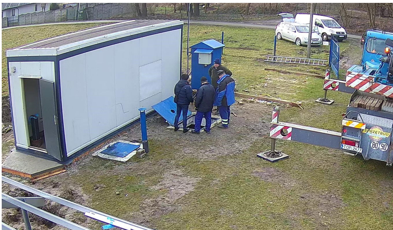
Renowacja studni nr 1 ujęcie Radzików II 1
