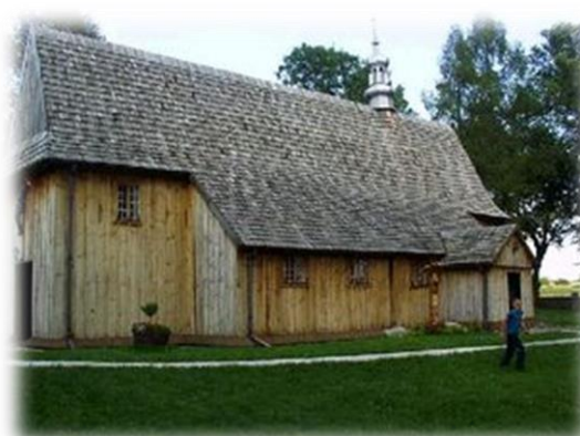
Fot. Nr 24 Drewniany kościółek w Strzegomiu
