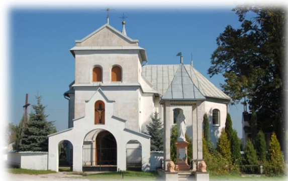
Fot. Nr 35 Kościół pw. Wniebowzięcia Najświętszej Marii Panny w Potoku
